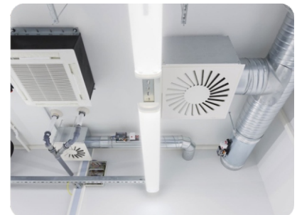
Sprzedaż urządzeń wentylacji / klimatyzacji
