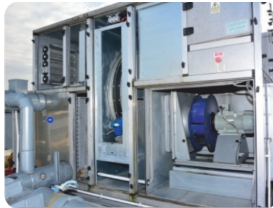
Czyszczenie Central Wentylacyjnych
